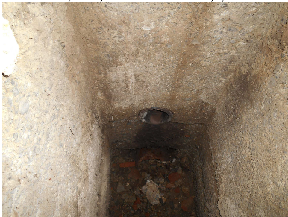
1. Pohľad do šachty čistiacej stanice z ulice – odtok do verejnej kanalizácie
